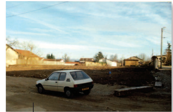
Grande Rue. Après démolition.
