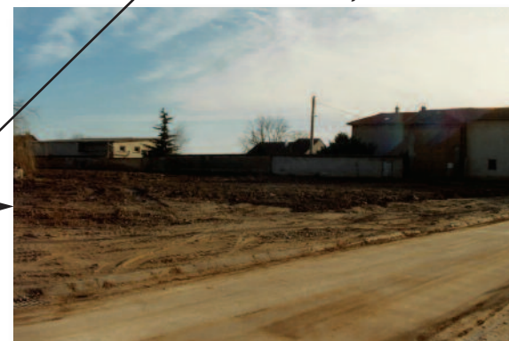
Grande Rue. Après démolition.
